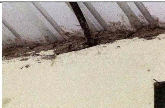
Foto 4: TRABAJO EN LA SOLERA CORONA PARA SELLADO DE GRIETAS
