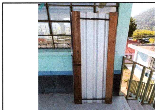
Foto 5: COLOCACION DE PUERTA SEGUNDO NIVEL
