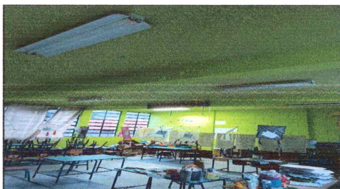
Foto 10: MANTENIMIENTO Y CAMBIO DE LAMPARA EN EL SISTEMA ELECTRICO 3 AULAS PRIMER NIVEL Y UNA EN EL SEGUNDO NIVEL
