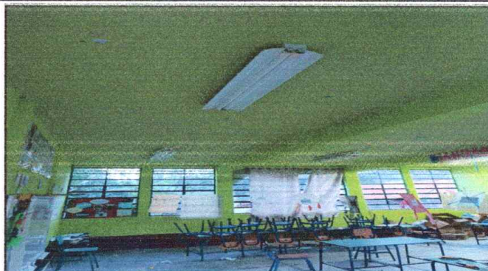
Foto 8: MANTENIMIENTO Y CAMBIO DE LAMPARA EN EL SISTEMA ELECTRICO 3 AULAS PRIMER NIVEL Y UNA EN EL SEGUNDO NIVEL
