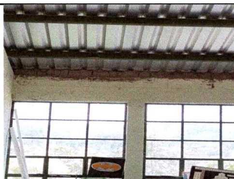
Foto 6: TRABAJO EN LA SOLERA CORONA PARA SELLADO DE GRIETAS
